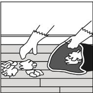
Eine trockene Reinigung zur Beseitigung von losem Schmutz, Schutt, Belagresten etc. durch Kehren bzw. Saugen.
